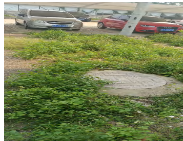
项目东南角已建的化粪池
