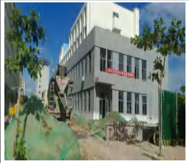
西面在建的新琼小学
